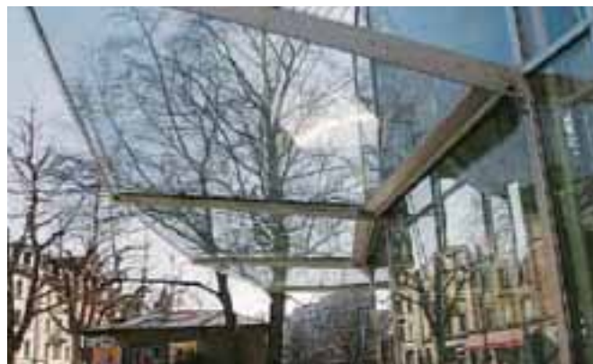
Tettoia con vetrata accessibile
